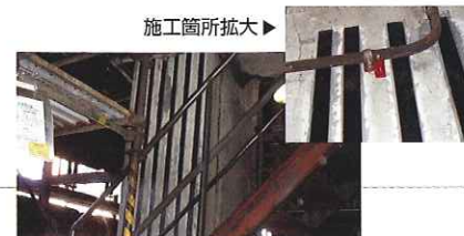
製油所のコンクリート柱の補強 限られた作業時間、狭小な場所で、火気厳禁の作業環境下においてもCABOCON工法では補強を行うことが可能。
