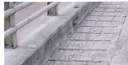
橋梁張出床版補強 今までは補強が行えなかった箇所もCABOCON工法では補強可能。
