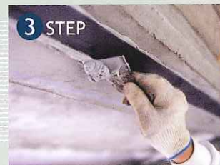
製油所のコンクリート柱の補強 限られた作業時間、狭小な場所で、火気厳禁の作業環境下においてもCABOCON工法では補強を行うことが可能。
