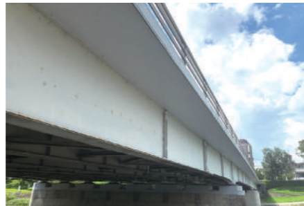
京都市役所 北山大橋補修工事
