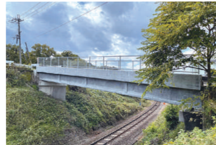
西日本旅客鉄道 笠置・加茂解放橋補修工事
