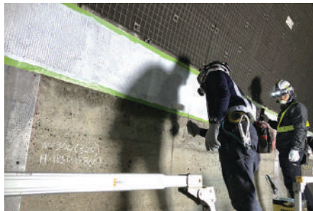
国土交通省 近畿地方整備局 国道2号夢前トンネル塗装補修工事
