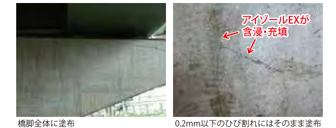
橋脚全体に塗布
