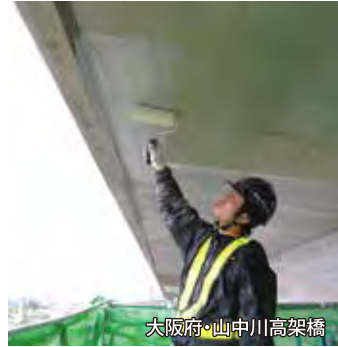
大阪府・山中川高架橋
