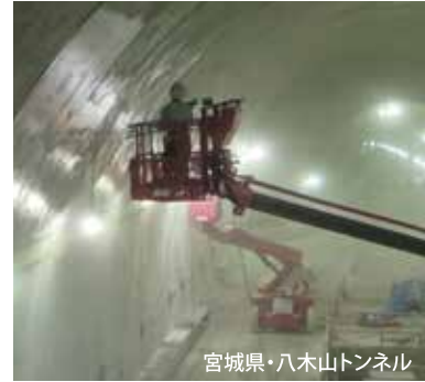
宮城県・八木山トンネル
