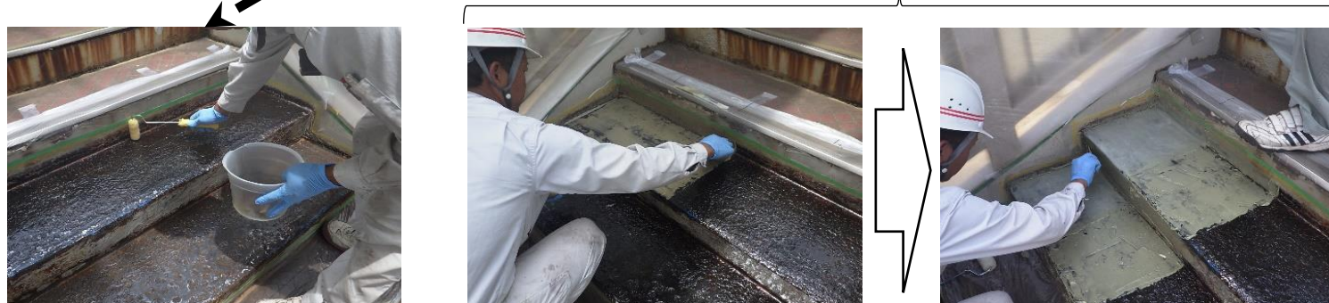
刷毛・ローラーで塗布 ⇒養生10分～30分
